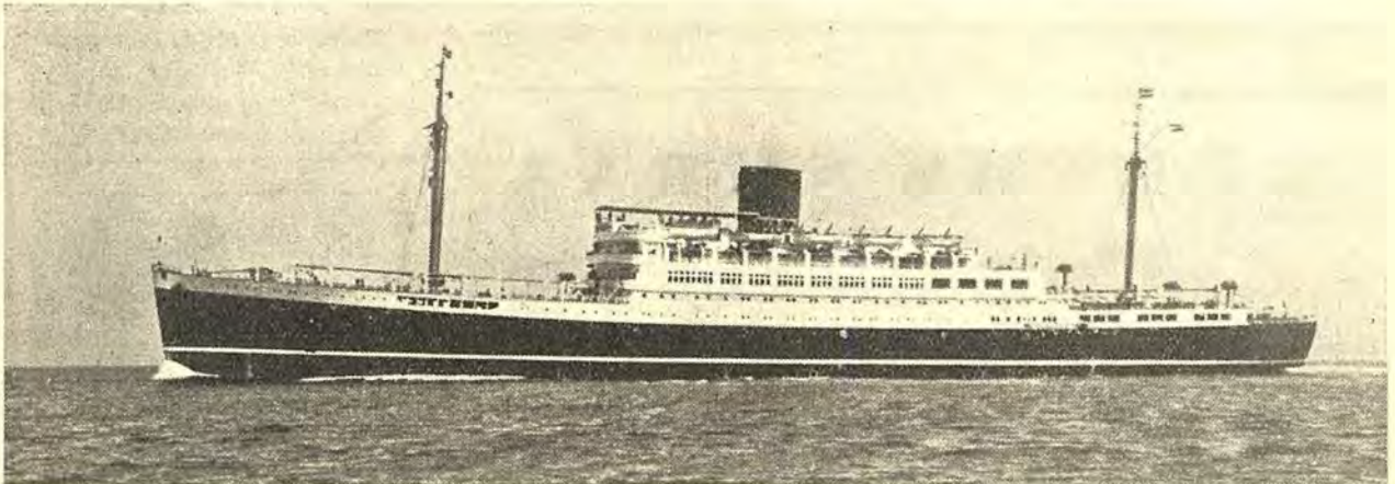
Damperen »Postdam«, hvoraf store Dele er elektrisk svejst.
