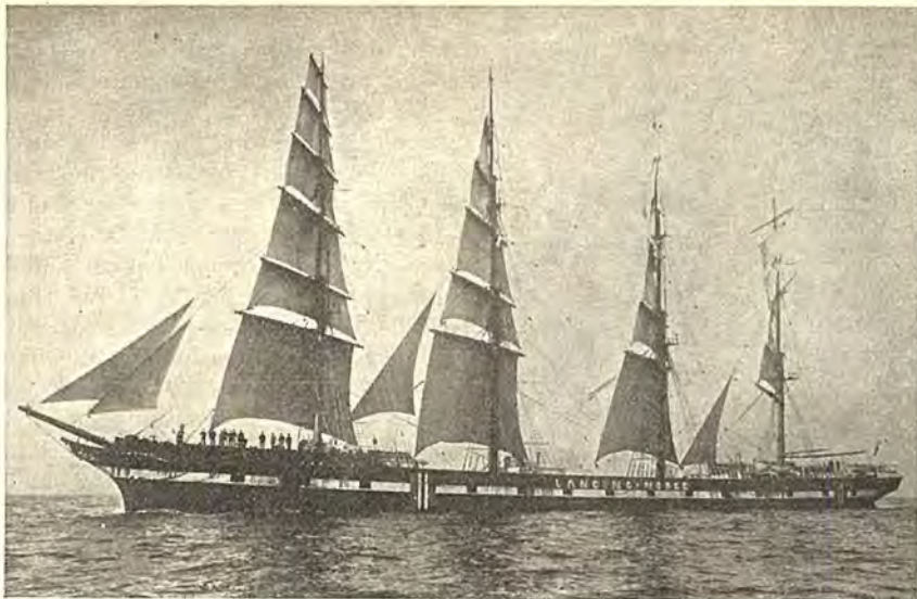
4-mastet Fuldkib „Lancing“, oprindelig bygget i Glasgow 1856 som Passager- og Postdamper „Pereire“ Le Havre—New York. 1888 blev Maskinen taget ud og Skibet forandret til 4-mastet Fuldkib „Lancing“, var paa 2785 B.T. I hele sin Levetid som Sejlskib viste den sig at være en Flyver med fortrinlige Rejser. Juleaften 1924 forlod „Lancing“ Adrossan med Kullast til Genua, hvortil den for £ 6000 var solgt til Ophugning. (Fra Lods Gruelunds Samling).
