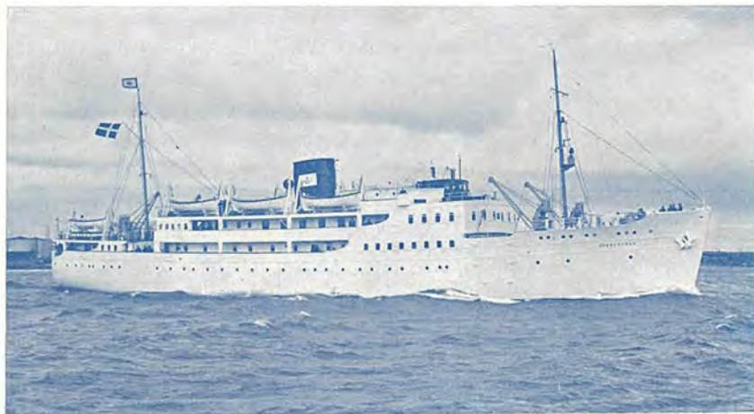
M/S „HAMMERSHUS“, Dampskibsselskabet paa Bornholm af 1866, Rønne, er udrustet med THRIGE helelektriske Styremaskine og THRIGE Dæksmaskineri, Dynamoer og Motorer
