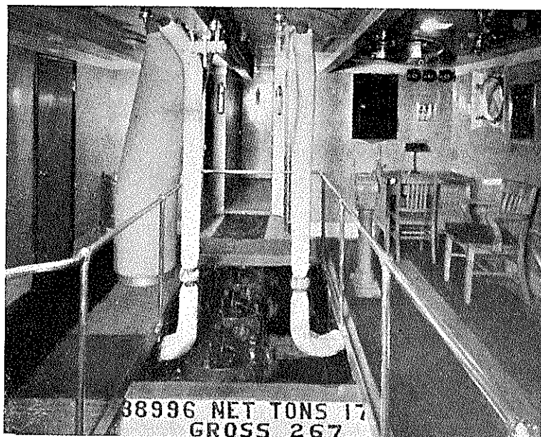
Manøvrepladsen er i Dækshuset med Overblik over Motorrummet.
