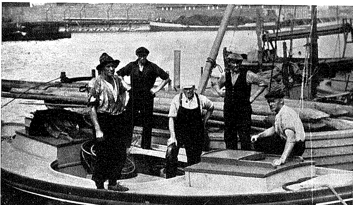
Fiskerbaad ved Djævleøen i Københavns Sydhavn. Langst til venstre Sydney, i Midten med Piben Arthur og yderst til højre Torres.
