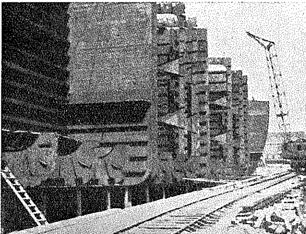
Skodder og Pladespanter i en Sidetank delvis færdig opstillede.
