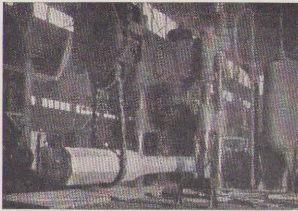
Fig. 4. Smedning af Akselemne i 1800 ts hydraulisk Presse.
