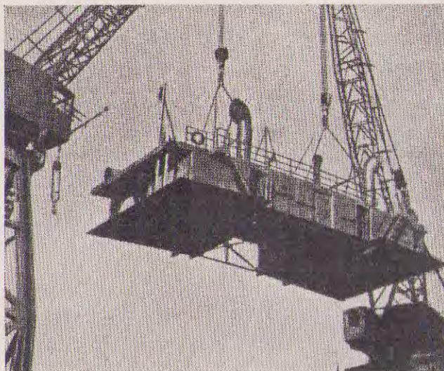
Halvdelen af et Dækshus løftet i to Kraner.
