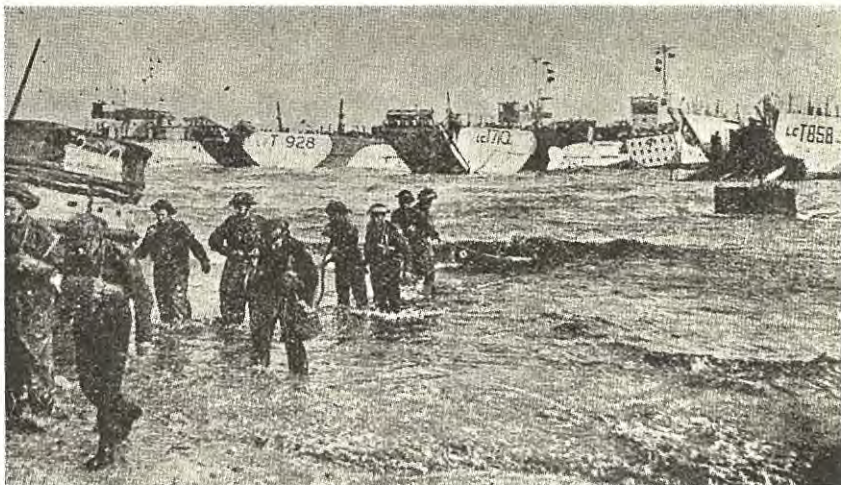
Paa Billedet ser man engelske Ingeniørsoldater trække Kabler lige efter Invasionen paa den nordfranske Kyst.
