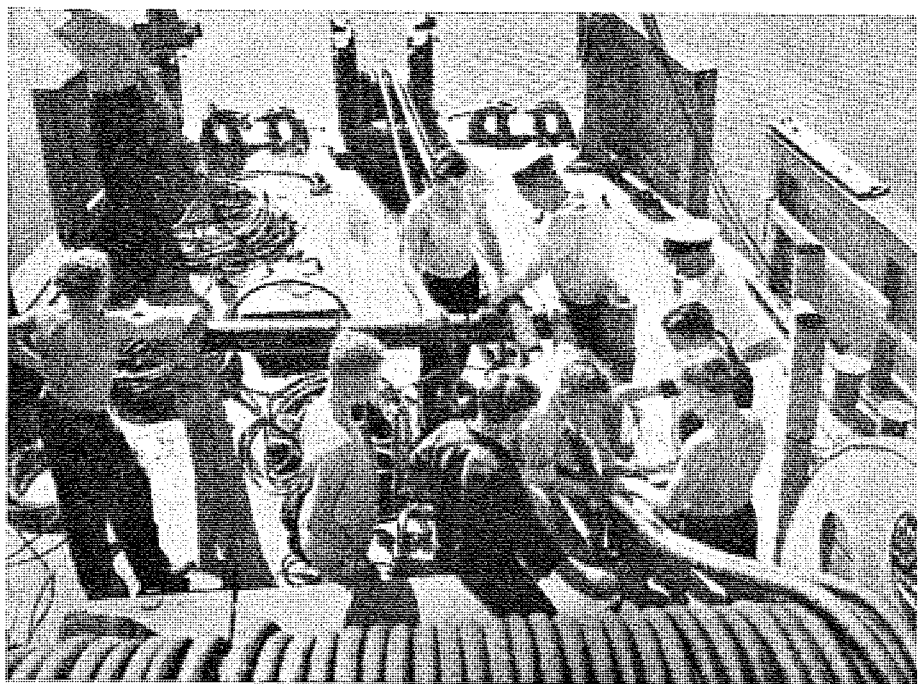
Et Kabel, der er havareret under Strygningen, repareres paa Agterdækket.
