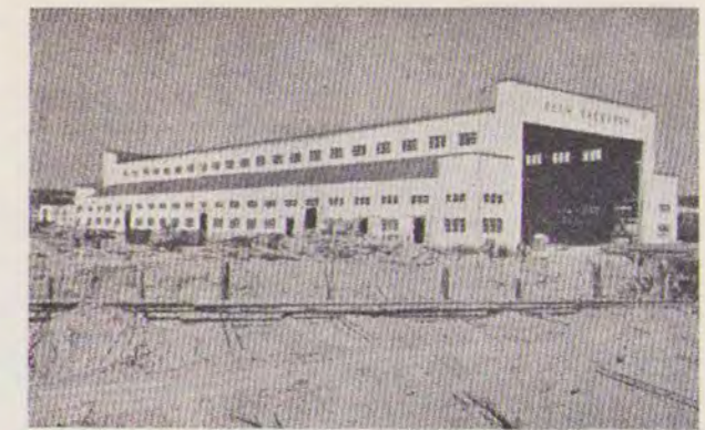
Dækshusene blev under krigen bygget færdige på transportbånd i store haller. Når de gik ud af hallen var alt snedker-, rør- og elektrikerarbejde færdigt. Vægt op til 210 tons.
