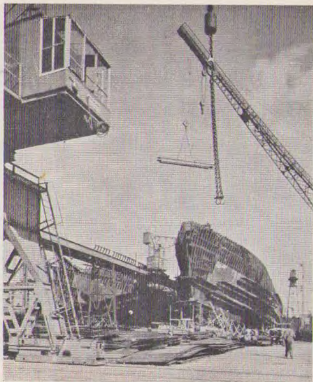
Beddingerne 3 og 4. I forgrunden en tværgående kran for materialernes fordeling.
