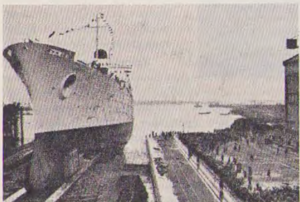
„Flandre“s stabelaflobning. Vulkonstruktionen af forskibet ses tydeligt.
