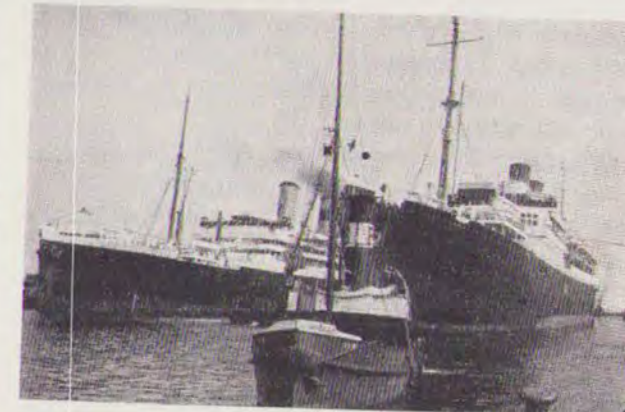
„Tyr“ bugserer S/S „Otranto“ af Liverpool ind i Frihavnen. Til venstre ses M/S „Cape Polonio“ af Hamburg. Billedet er taget i 1926. Det viser ligesom de øvrige „Tyr“ uden styrehus. Først efter en af de senere, hårde isvintre fik „Tyr“ lukket styrehus. Iøvrigt har „Tyr“ påmonteret stang på masten på alle de her viste billeder. Stangen, der nu er fjernet, stammer fra den tid, hvor bugsererselskabet konkurrerede med Svitser og derfor fik radio og antennemast om bord.
