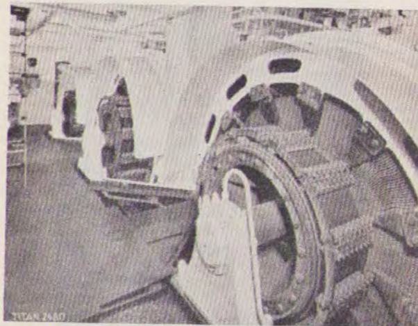
533 kW. comp. dynamoer, 220 volt D. C., 300 omdrejninger/min. (Titan).
