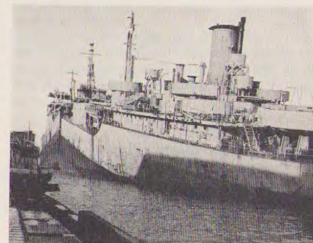
Et helsvejt tankskib brækkede med et brag midt over, mens det var til reparation på Hedbloms værft.
