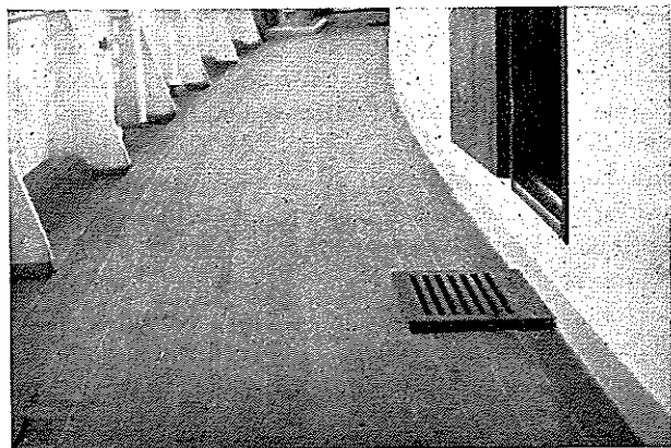
Dette billede viser en skibsgang med dæk kalfatret efter den ny metode. Plankerne indpresset efter en radius på 27 meter. I nævnte tilfælde er benyttet oregonpine-planker 5×3 tommer, længden over 35 fod. Lægningen voldte intet besvær, og man kunne således udnytte træmaterialerne fuldt ud.
