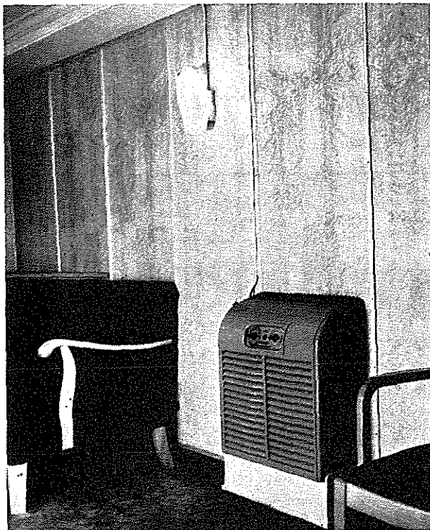
HI-PRESS luftkonditioneringskabinet. Reguleringsknappen til venstre styrer lufttemperaturen, medens knappen til højre regulerer luftmængden. Friskluften træder ud gennem risten foroven i kabinettet, medens returluften indsuges gennem jalousiet på kabinettets forside til opvarmning eller afkøling i kabinettets indre.
