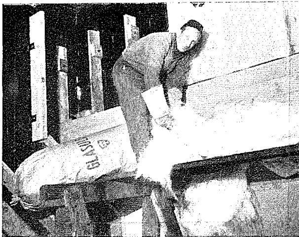
Glasuld-materialer stoppes med en rumvægt af 60 kg/m.
