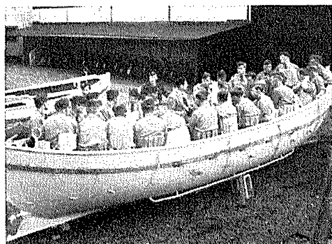
Langskibsstyrken er stor trods den lille egenvægt. En 24' båd vejer 755 kg. Nedbøjning målt ved fuld belastning: 3,5 mm. Tilladelig nedbøjning 1/400 X L. Pladsfordeling opmålt med mandskab iklædt redningsbælter viser i praksis bådernes fordelagtige konstruktion
