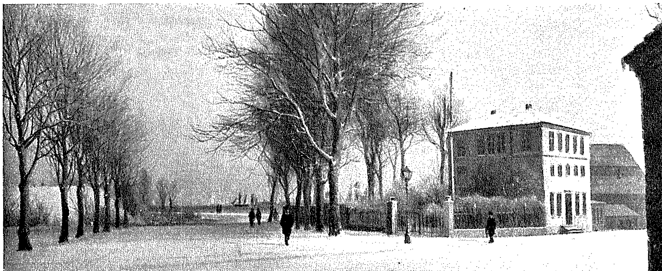
Firmaets gamle kontorbygning på Toldbodvej.
