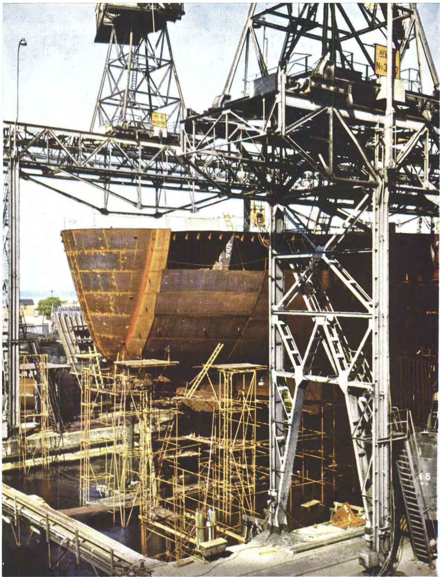
Skibsbygning - Reparationer - Dieselmotorer
