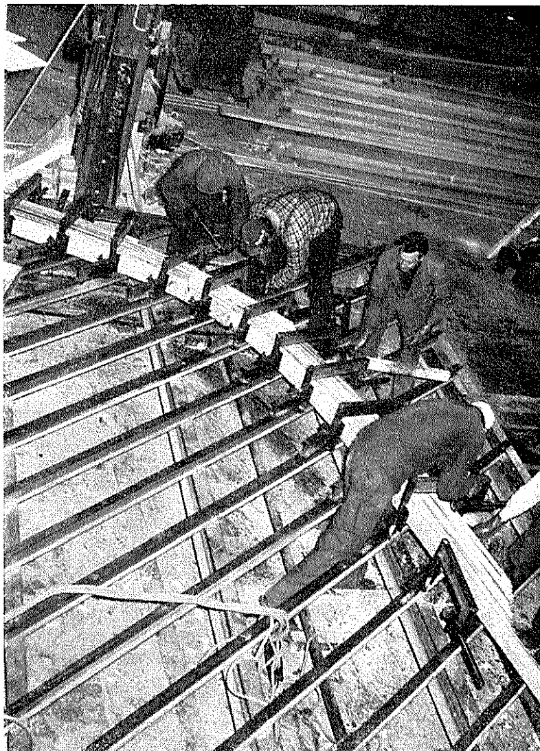
Et spant presses og formes.
